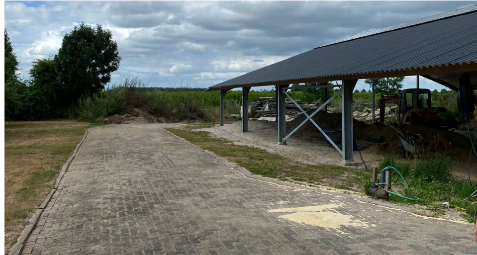
Afbeelding 8. Noordelijk (gebiedsvreemd) bijgebouw en zichtlijn met bestaande randbeplanting.
