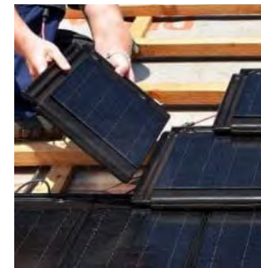
Afbeelding 29. Referenties integratie van zonnepanelen in all-in dakoplossing.
