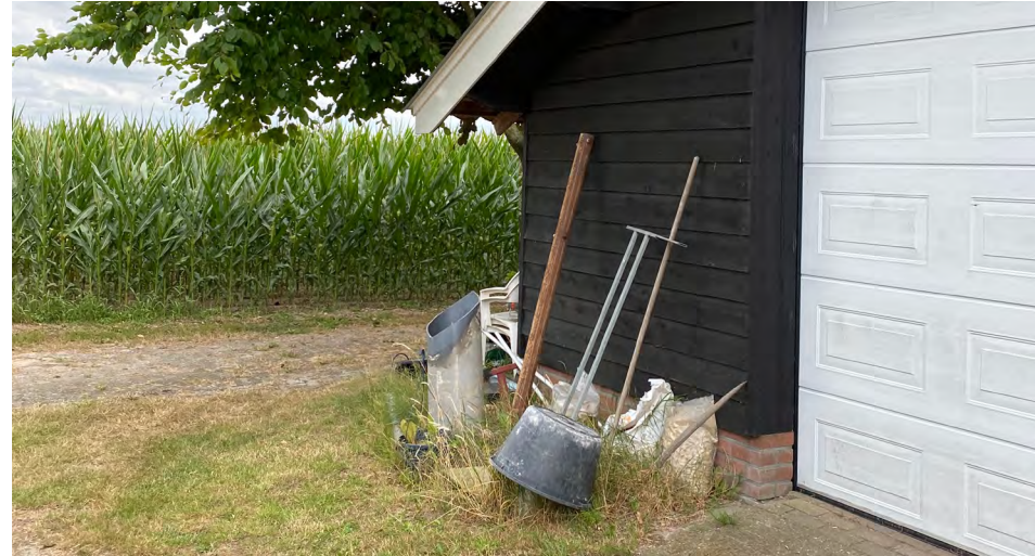
Afbeelding 5. Te behouden schuur met poort aan noordzijde en toegang via oostzijde achtererf.
