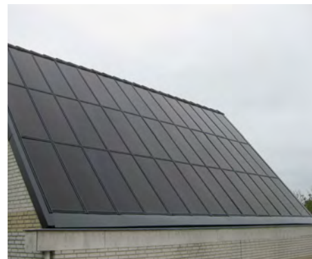
Afbeelding 29. Referenties integratie van zonnepanelen in all-in dakoplossing.
