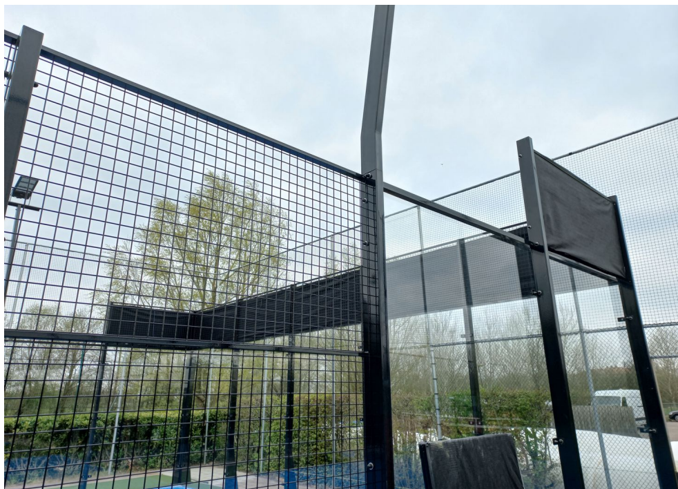
f6 Situatie 2 met 28 geluidsabsorberende panelen
