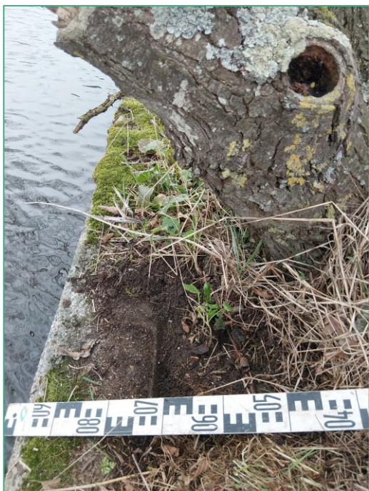
Afbeelding 4.4 Afstand stamvoet boom tot damwand
