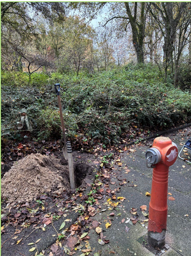
Figuur H: Overzicht van proefsleuf ter hoogte van nieuw aan te leggen pad.
