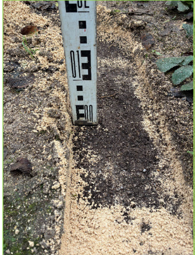
Figuur K: Overzicht van 5 cm dikke toplaag halfverharding.
