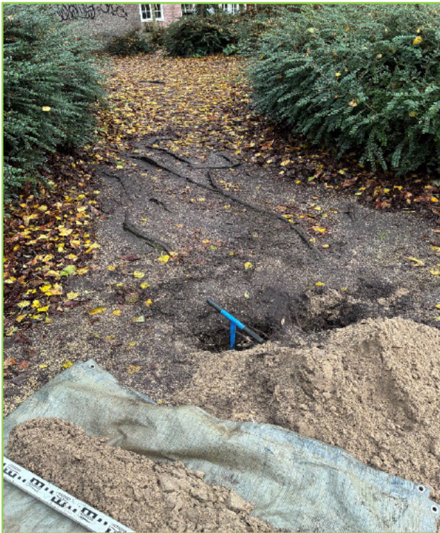
Figuur 11: Grondboring in de halfverharding op 3 meter van boom 93.
