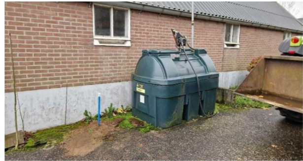
Figuur 10: Bovengrondse dieseltank
