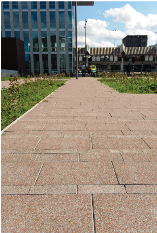
Betontegels (Struykverwo) 50x50x6 cm Breccia, kleur: vergelijkbaar als gebruikt in de gevel
