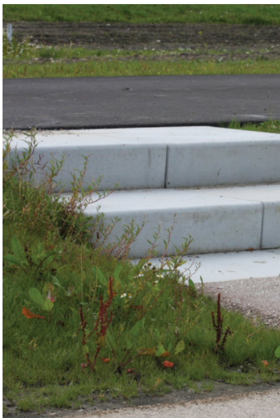
Betonnen traptreden prefab 40x100x20 repeteer (Struykverwo) kleur: Breccia ambrogio 670
