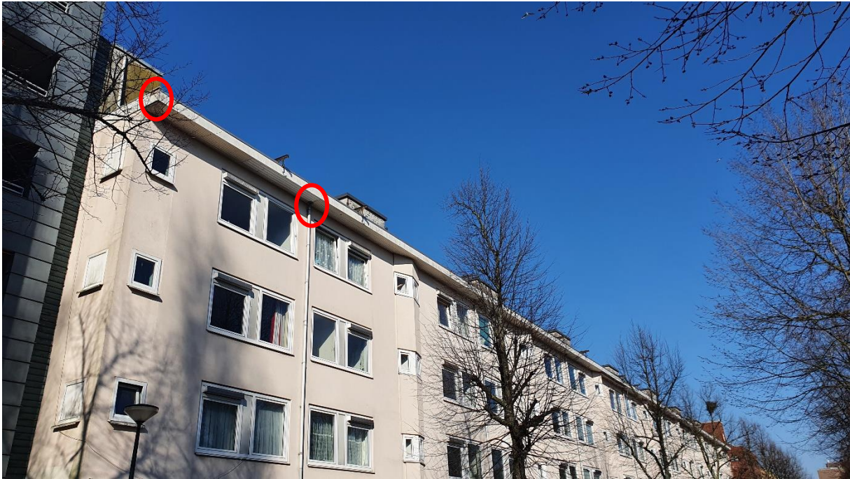
Afbeelding 5.1: kleine openingen (rood omcirkelt) in de dakrand en bij hemelwaterafvoer waar vleermuizen mogelijk gebruik van kunnen maken.
