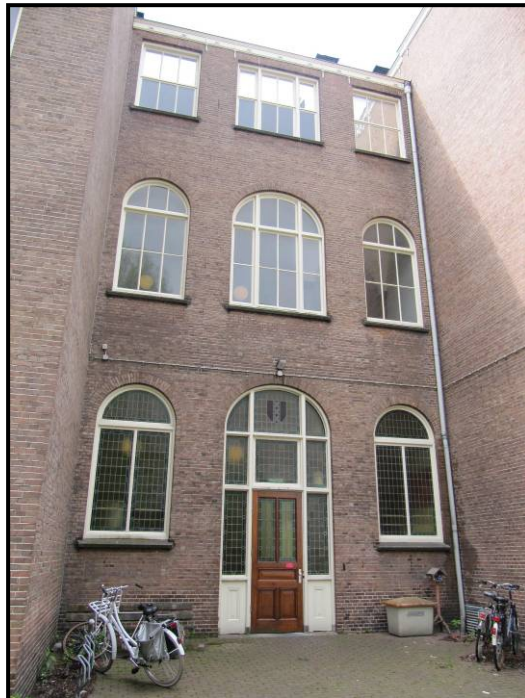
Afb. 11. Deel van de achtergevel, met het centrale terugspringende deel met de achterhoofdingang. Achter de vensters bevinden zich de hallen op de begane grond. en de twee verdiepingen.
