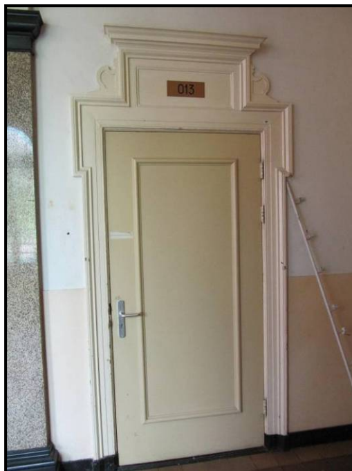
Afb. 13. Deur en deurkozijn met bovendeurstuk in de corridor op de begane grond.
