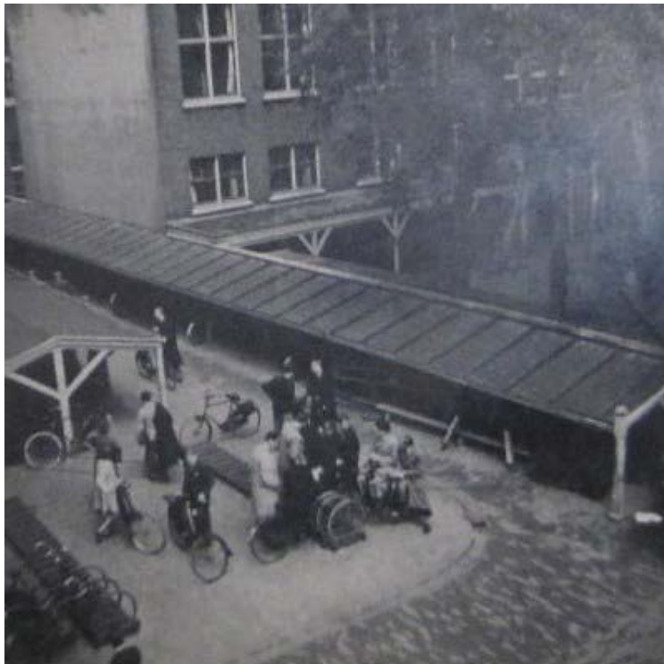
Afb. 30. Ongedateerde foto uit de periode van circa 1910-1920, van de binnenplaats richting het Noordoosten. Hier bevonden zich twee uit de bouwtijd stammende overdekte fietsenstallingen. De lange stalling vormde tevens de afscheiding met het belendende terrein, waar zich het schoolplein van de school aan de Passeerdersgracht 23-25 bevond. De binnenplaats is hier deels bestraat. De constructie van de fietsenstalling vertoont enige gelijkenis met die van de kapconstructie van het gymnastiekgebouw.
