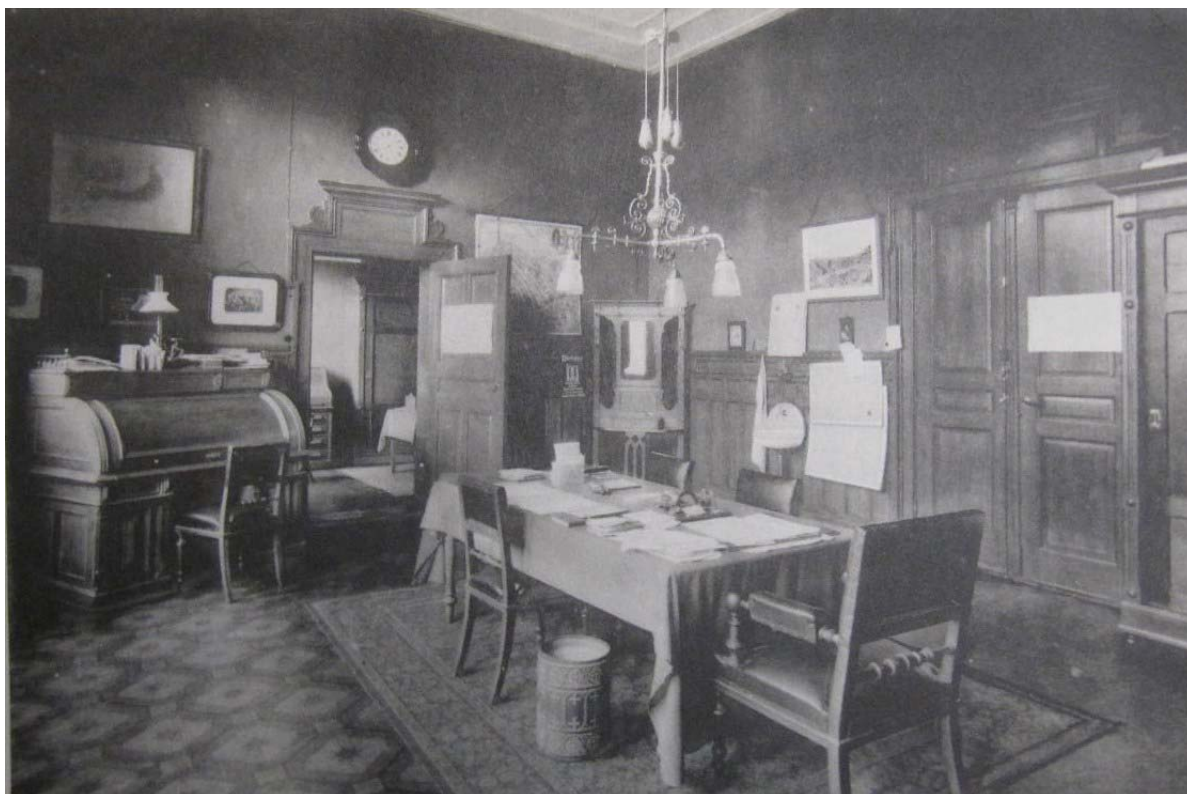
Afb. 22. Foto van de directeurskamer op de eerste verdieping afkomstig uit het 50-jarige gedenkboek van de Handelsschool, uitgegeven in 1919. De kamer was verbonden met het naastgelegen vertrek. In het midden boven is een detail van het stucplafond zichtbaar, uitgevoerd met een dubbele lijst.
