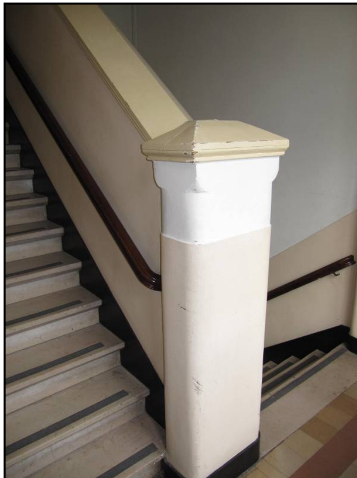
Afb. 24. Detail van een van de trappenhuizen.
