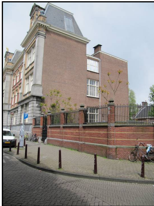
Afb. 9. De zuidelijke korte gevel van het schoolgebouw, met in het midden de vensters van de corridors. In de kap bevindt zich de deur voor de inmiddels verdwenen hijsinstallatie. Op de voorgrond het oorspronkelijke hekwerk dat de binnenplaats afsluit, met links in het hekwerk het toegangshek naar de binnenplaats.
