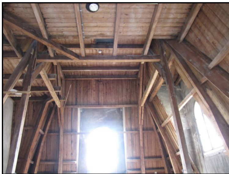
Afb. 25. De kapconstructie van de noordwestelijke risaliet.
