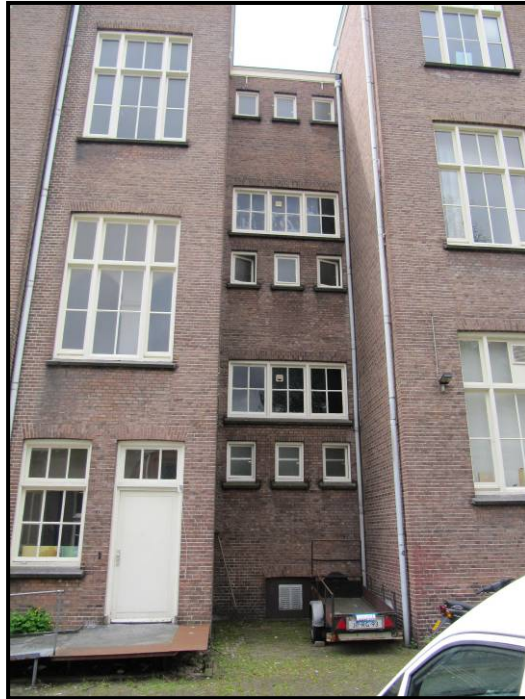
Afb. 10. Deel van de achtergevel, met in het terugspringende deel de vensters van de toiletruimtes. Links bevindt zich de toegangsdeur tot een van de trappenhuizen.
