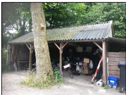
Foto 28. Beschutte plekjes onder de open kapschuur bij de schoolwerktuinen
