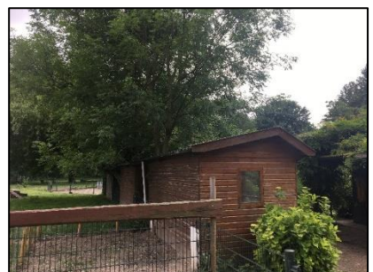
Foto 27. Openingen onder het dak van de schuur op de kinderboerderij
