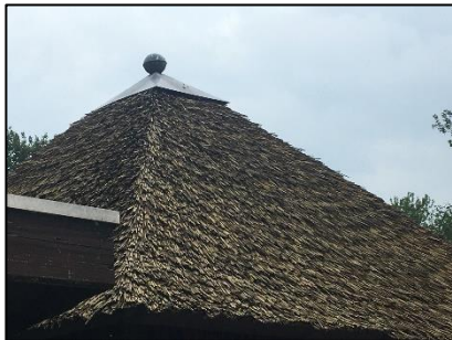
Foto 22. Opening tussen metalen dakpunt en strodak van gebouw op de kinderboerderij
