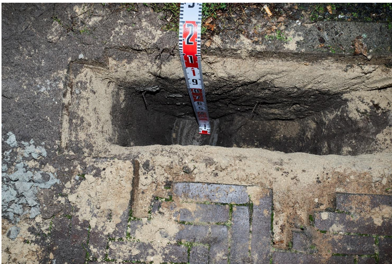
Foto 3: Profielsleuf aan de oostzijde van boomnummer 2.
