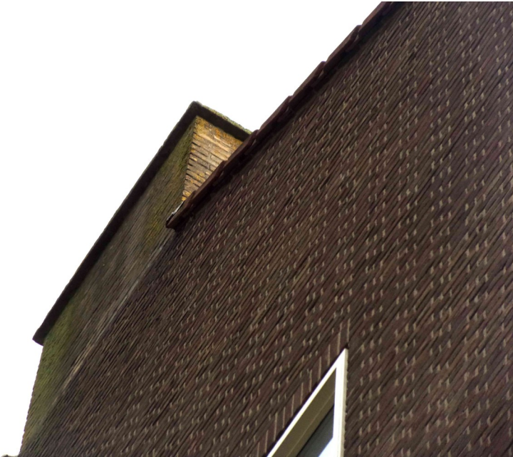
dakrand noordgevel met schuilmogelijkheid voor vleermuizen, tussen dakpanrand en gevel
