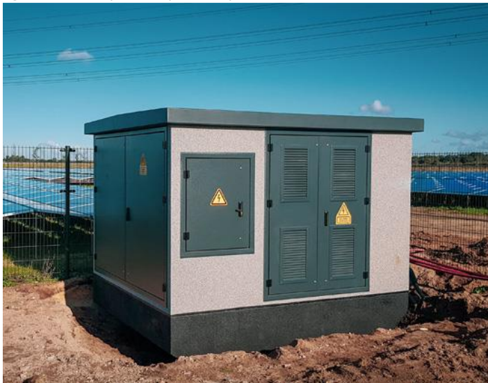
Figuur 4.8: Inkoopstation (indicatief)
