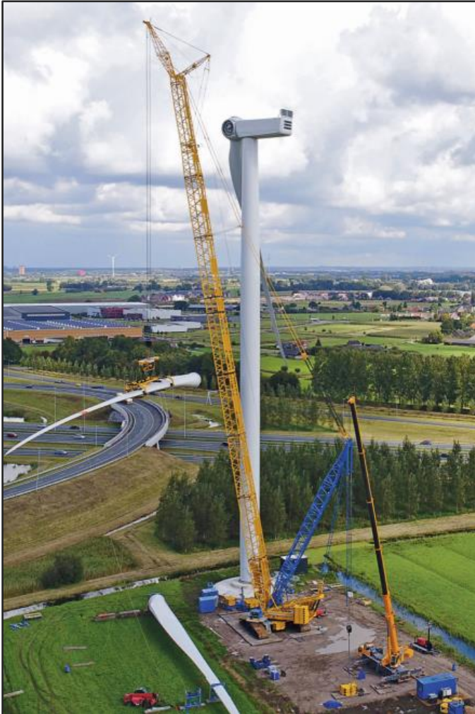
Figuur 4.7 Voorbeeld kraanopstelplaats (indicatief)
