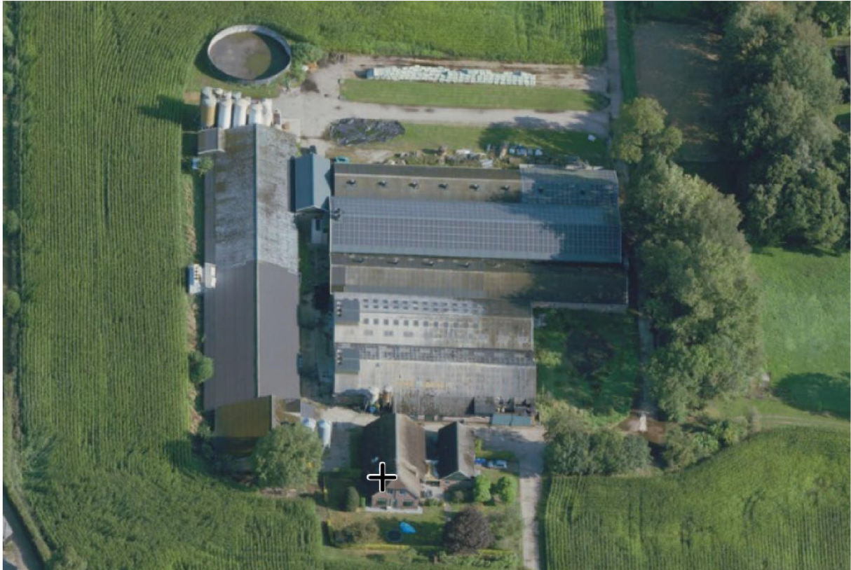
Afbeelding 3. Bouwlocatie Velnerweg 1 (Bron: Street Smart)
