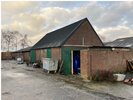
Figuur 5. Technische ruimten in de zw-hoek.
