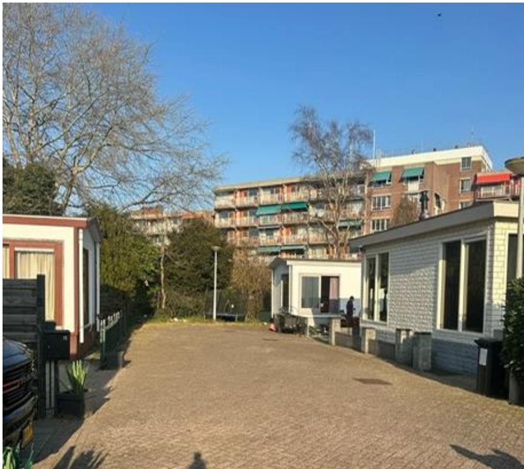
Een kijkje in het straatje met de andere woonwagens, allemaal bestaand uit 1 woonlaag
