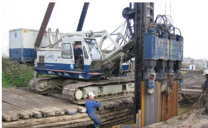
Foto 1 voorbeeld rupskraan met een Quattro piler
