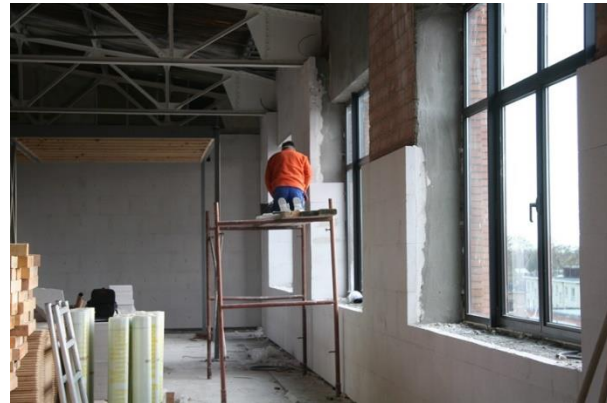
Isolatie gasbeton tegen metselwerk
