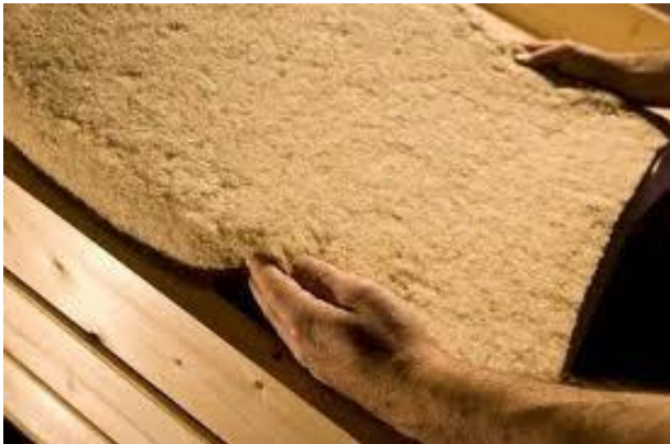
Vlasdekens tussen constructiedeel
