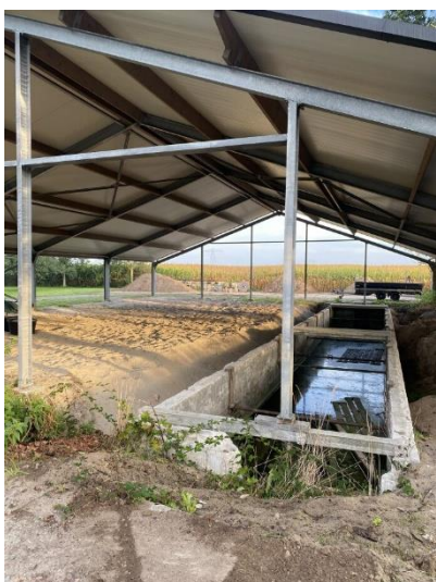
Afbeelding 7. Kelder met water, situatie op 27-09-2023.
