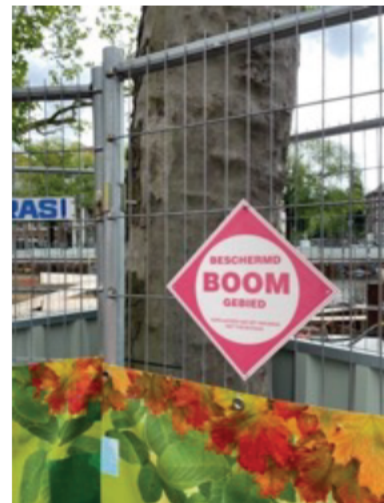
Afbeelding 40: Een vast hekwerk rond de groeiplaats (boomspiegel of plantvak) biedt betere bescherming.
