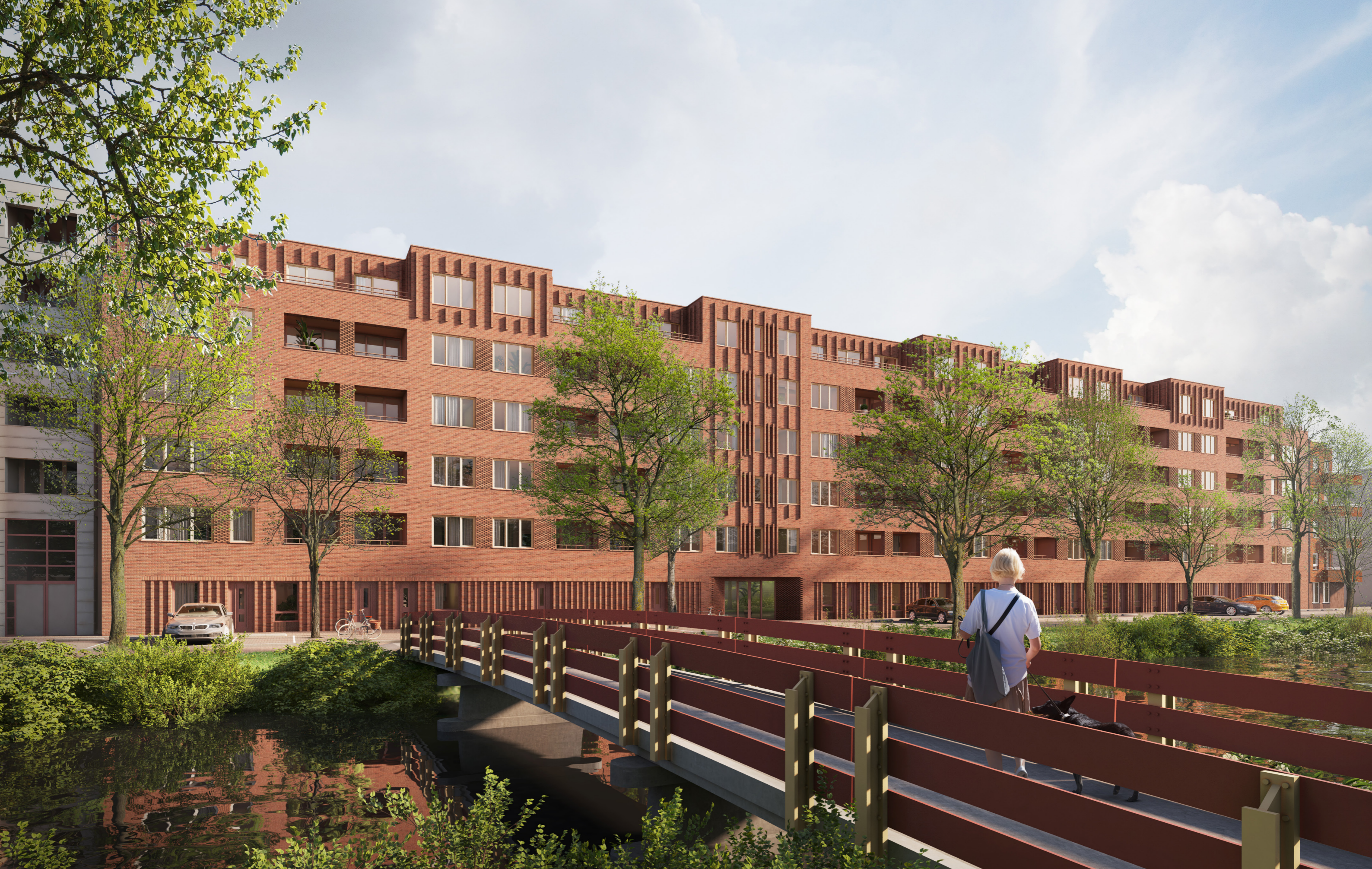
VOORGEVEL Aanzicht vanaf westzijde
