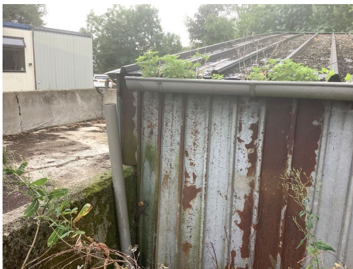
Afbeelding 5: Afdruipzone dak 3
