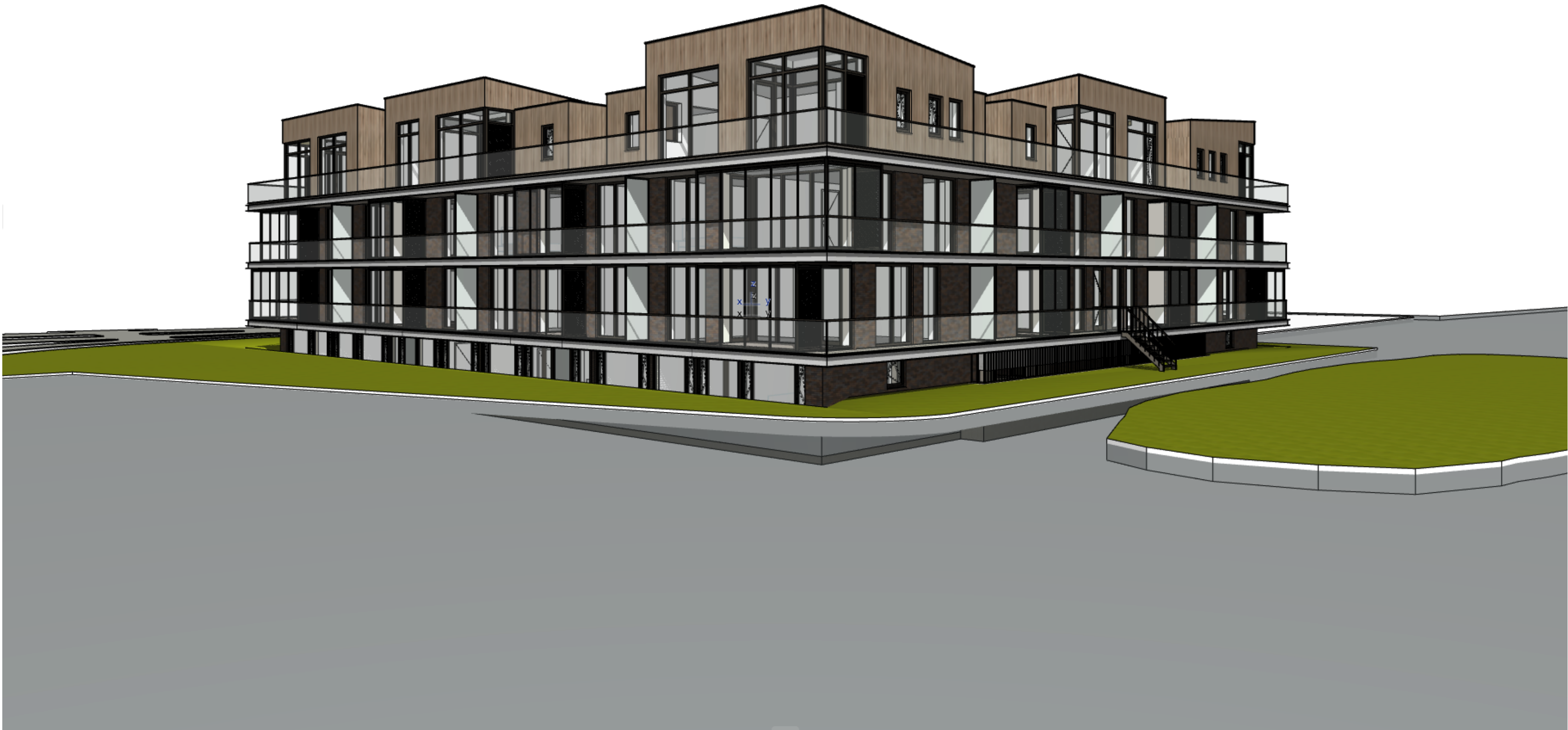
Aanzicht vanaf de Peilscheidingskade, linkerzij- en achtergevel
