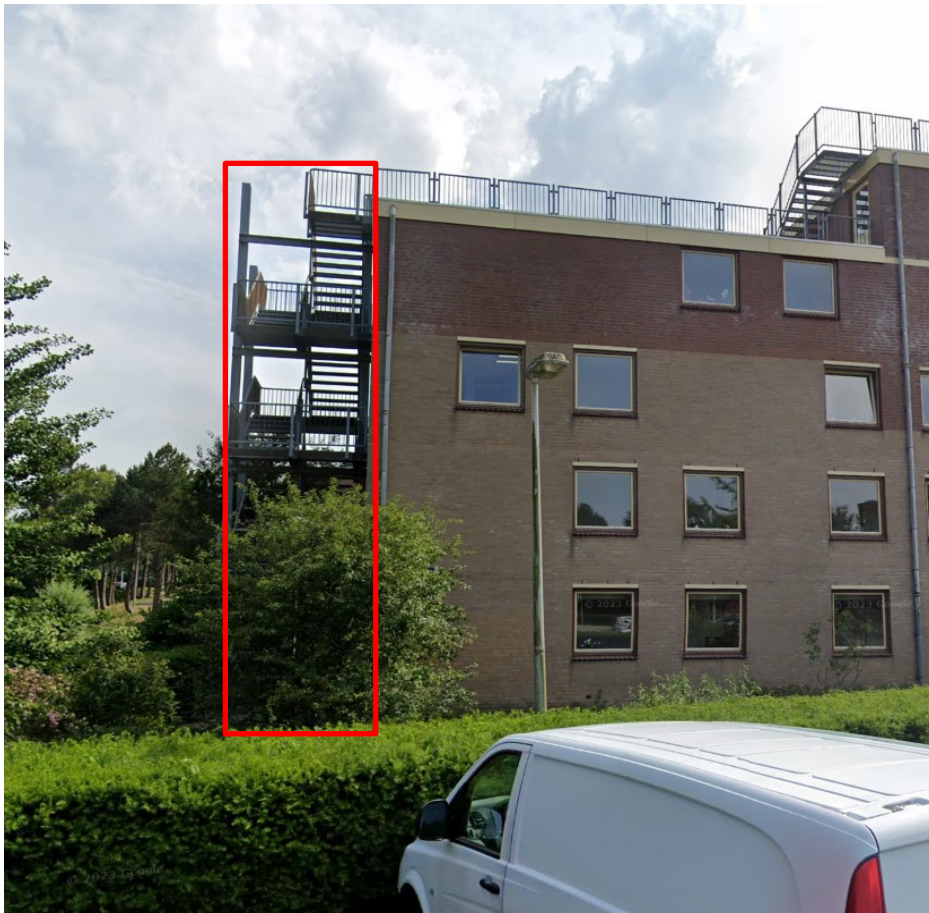
Afbeelding 2: de stalen vluchtweg, uitbouw van bestaand gebouw op afbeelding 1.
