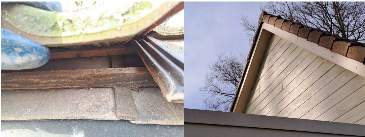
Foto links; er zijn geen huismusnesten onder onderste rij dakpannen vastgesteld. Foto rechts; de gevelpannen sluiten strak aan.
