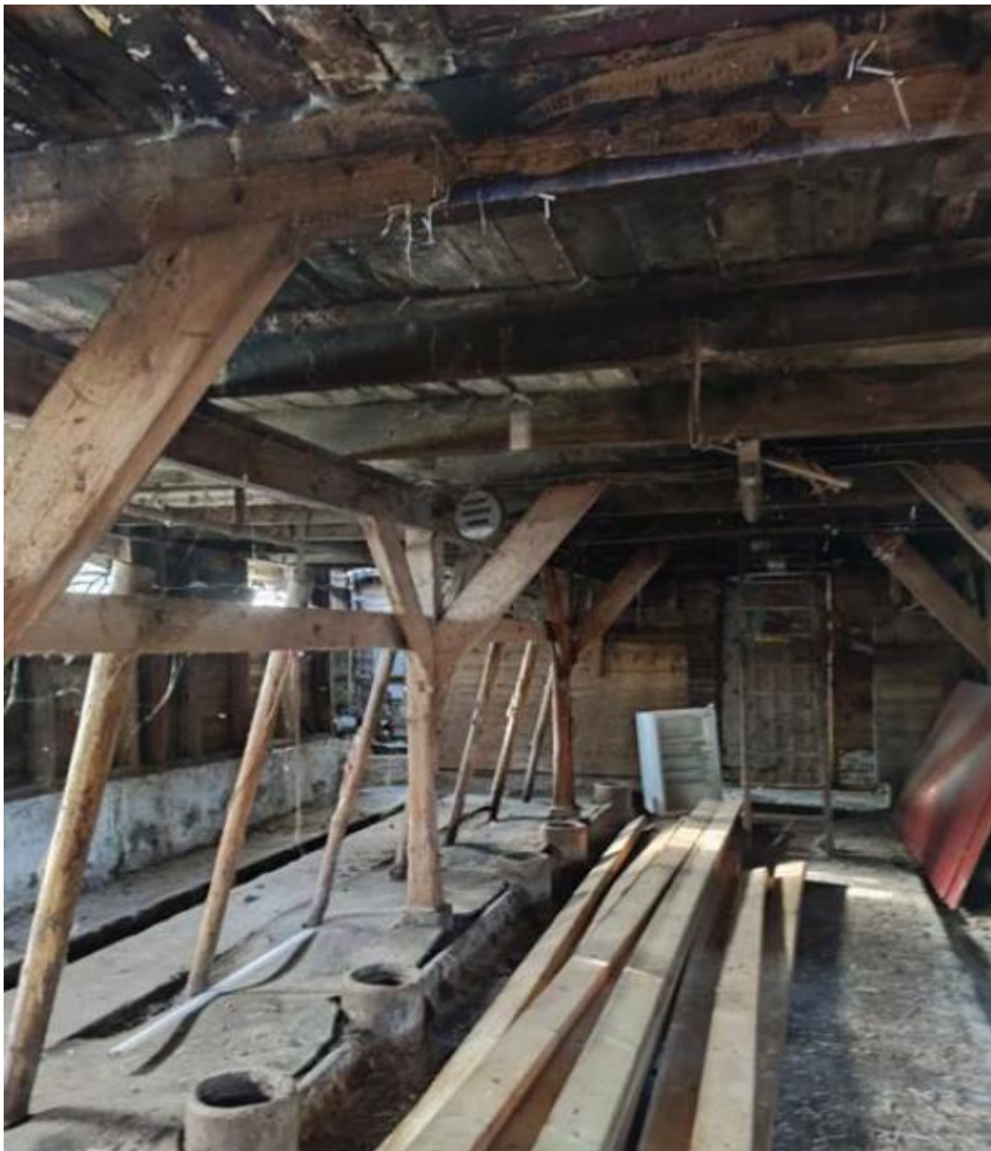
Spanten met korbelen
