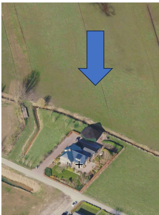
Figuur 1. bouwlocatie Zalkerveerweg nabij nr 4 (Bron: Street Smart) (5 maart 2022)
