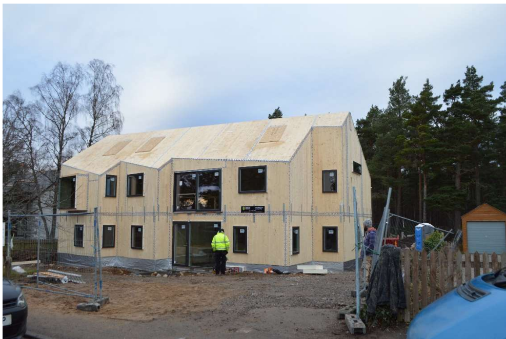
Figuur 1. CLT woongebouw in aanbouw
