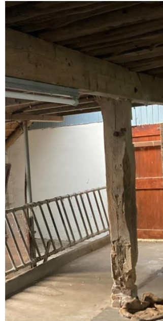
Fig. 1: Afgezaagde gebintpoot herstellen; staalconstructies en extra (later aangebrachte) randbalken verwijderen.
