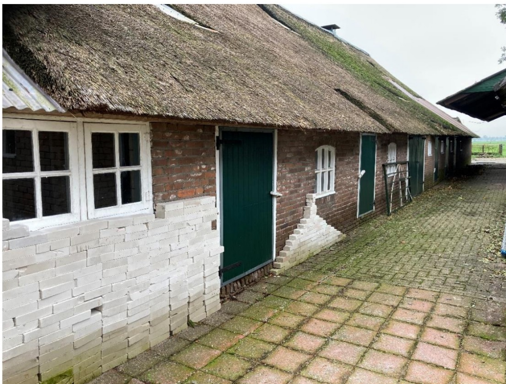
Fig. 11; Metselwerk schoonmaken en opnieuw invoegen; stalen deurvlakken vervangen door daglichten of houten deuren.
