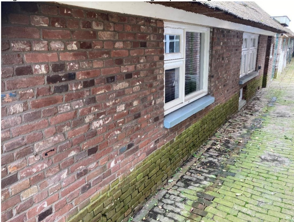
Fig. 9; metselwerk reinigen en opnieuw invoegen. Kozijnen en raamdorpels indien nodig op termijn restaureren.
