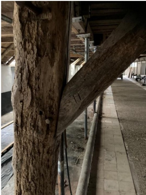
Fig. 1: Afgezaagde gebintpoot herstellen; staalconstructies en extra (later aangebrachte) randbalken verwijderen.
