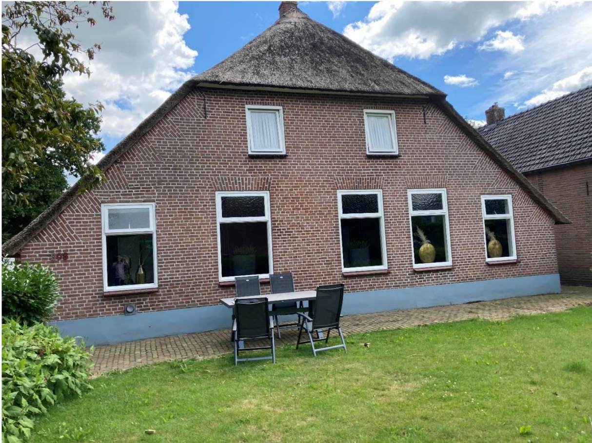
Fig. 18; Voorgevel; metselwerk nog behoorlijk gaaf. Gevelindeling voorlopig zo laten; op termijn voordeur evt. terugbrengen naar oorspronkelijke indeling en kozijnen bij vervanging meer historiserend uitvoeren.
