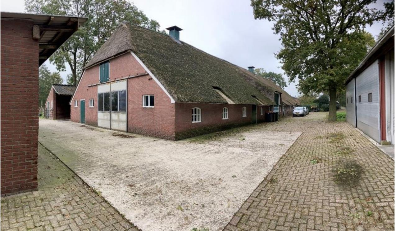
Fig. 14; achtergevel/ oostgevel; stalen schuifdeuren vervangen door houten pui; hooiluik herplaatsen met openslaande luiken; Kleine stalramen vervangen door iets grotere met boventoog. Rollaag boven en kleine lekdorpel beneden. Ramen in oostgevel behouden; ivm. nieuwe entree iets verschuiven; wel met rollaag erboven en kleine lekdorpel eronder.
