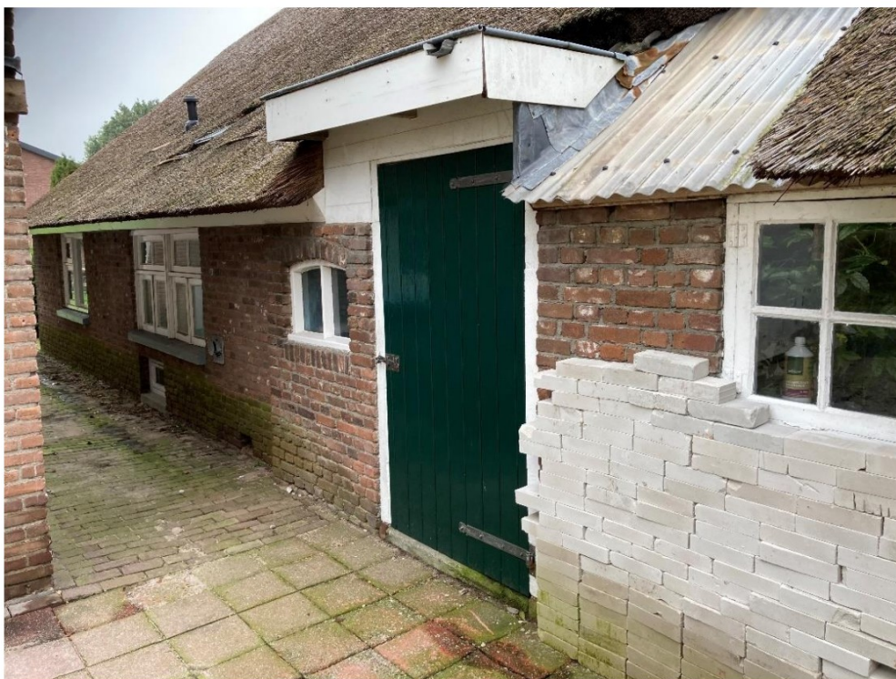
Fig. 10; metselwerk schoonmaken en opnieuw invoegen; gevelindeling zie doc. 618-onderbouwing aanpassingen gevels.
