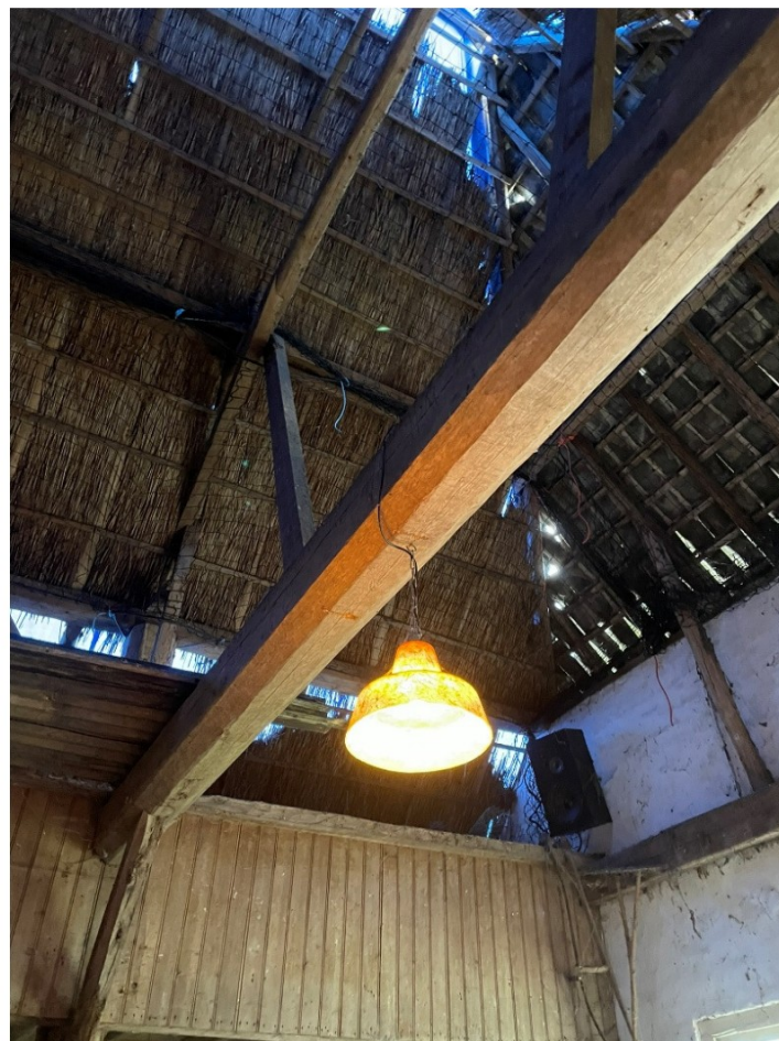
Kapconstructie van de deel
