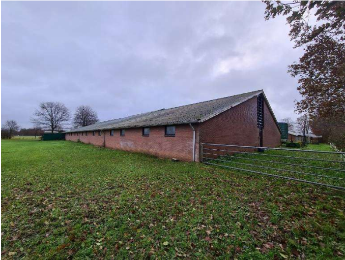
Figuur 2.1: noord- & westgevel
