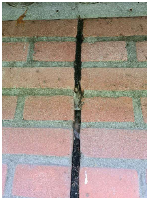
Figuur 4.2: gedeeltelijk ontbreken band
