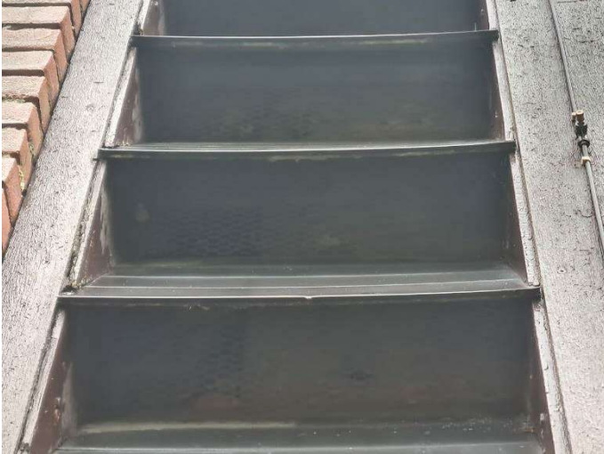
Figuur 3.5: gaasnet in luchtinlaat - buitenzijde
