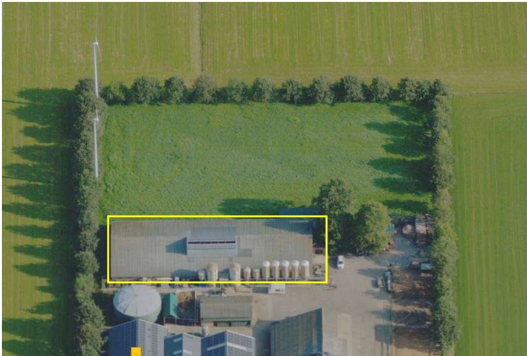
Figuur 1.1: ligging van het perceel en het te verbouwen gebouw (geel omlijnd). Bron: Cyclomedia
