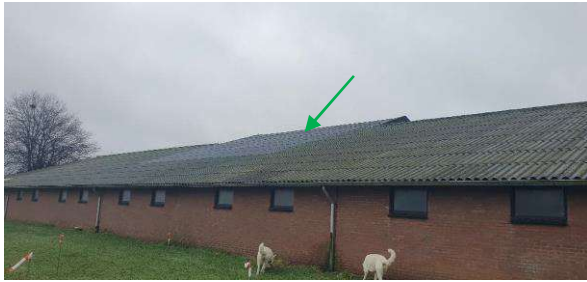
projectfoto opbouw 2000 NT golfplaten
