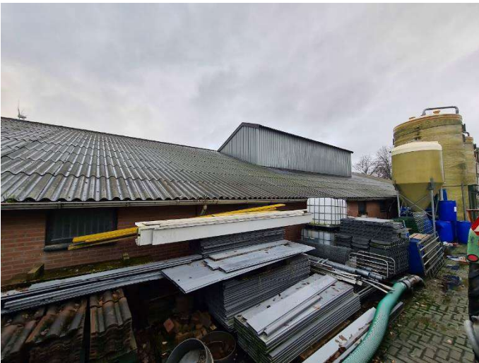
Figuur 2.3: zuidgevel + dakopbouw
