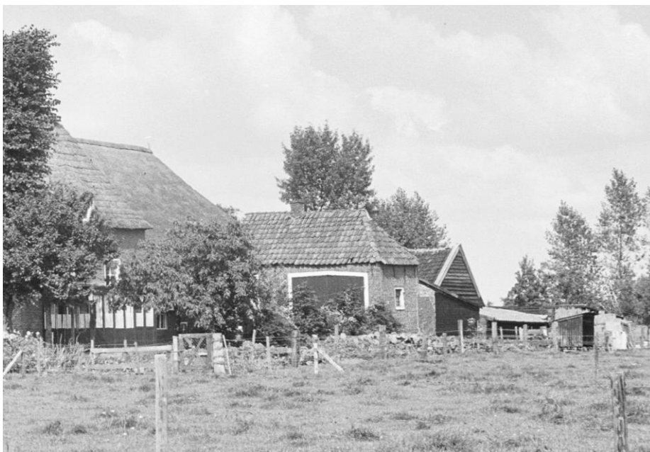
Boerderij met koetshuis vanuit het zuiden, 1966. Bron: RCE, 115.292b.
