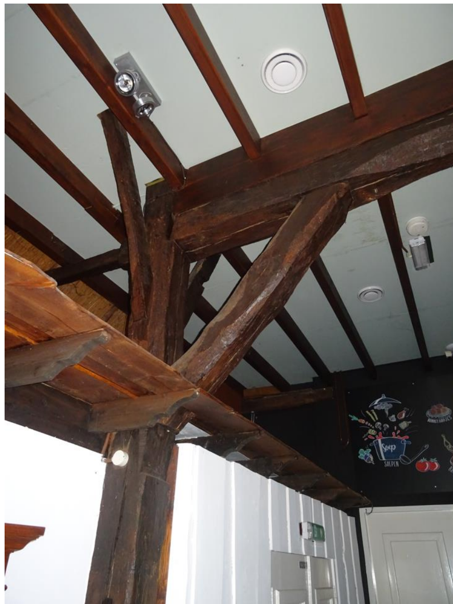
Ankerbalkgebint in de schuur.
