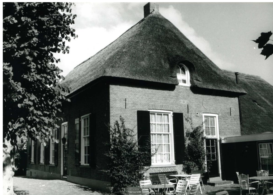
Het voorhuis vanuit het zuiden, 1986. Bron: Beeldbank Overijssel.
