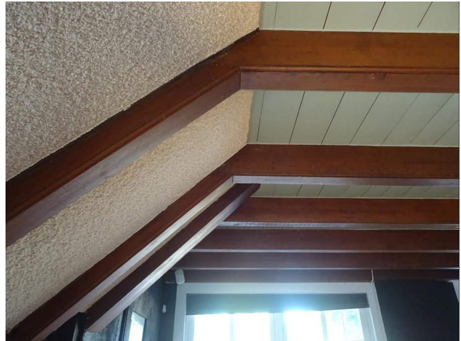
Impressie constructie koetshuis 1976.
