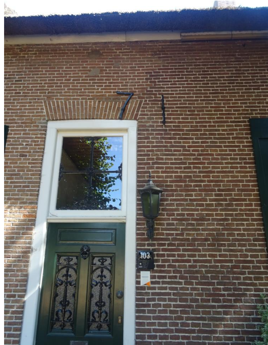
Voorgevel: metselwerk uit 1757 (links) en 1875 (rechts).
