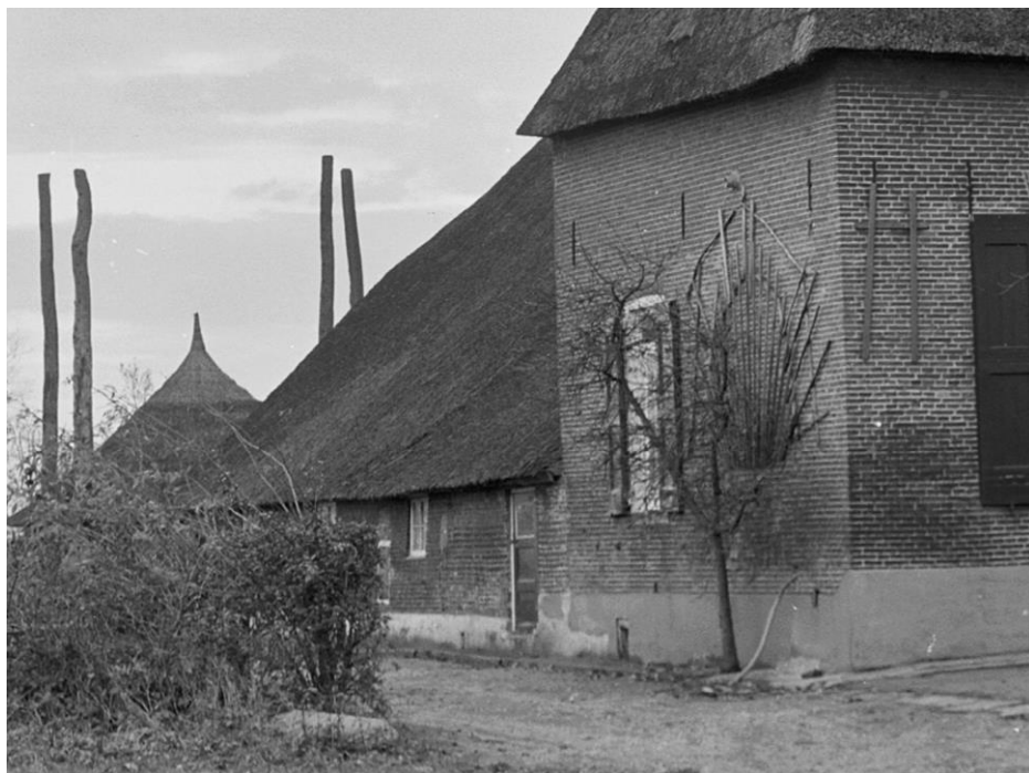
Zijgevels noord, 1956. Bron: RCE, 111.297.
