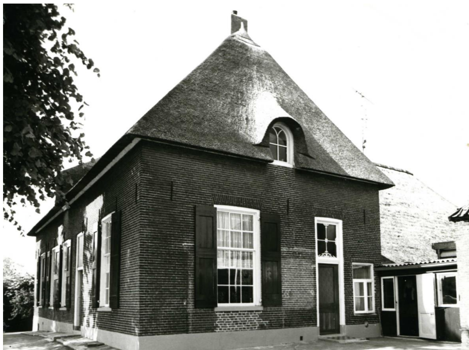
Het voorhuis vanuit het zuiden, 1974. Bron: Beeldbank Overijssel.
