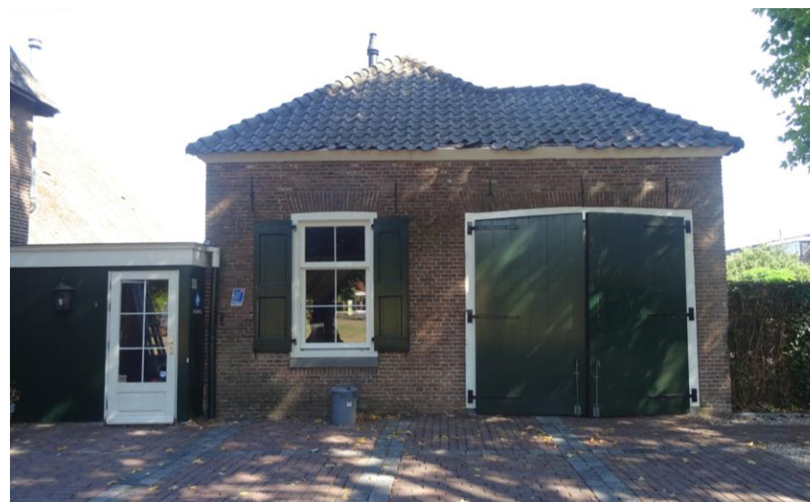
Koetshuis, voorgevel west, 2022.
