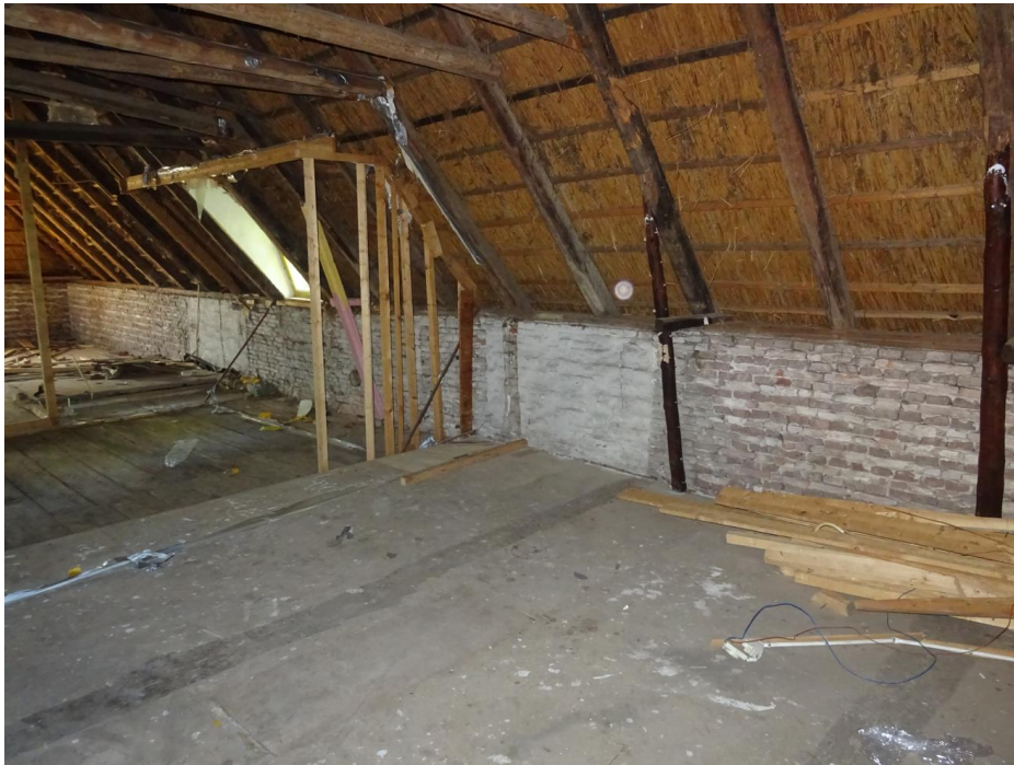
Zolder: impressie borstwering voorgevel met bouwsporen uit 1757 en 1875.
