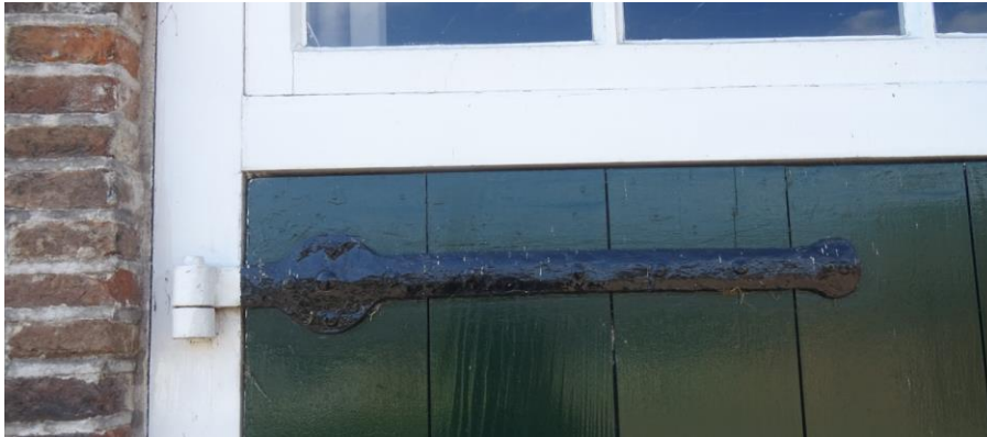
Oude gehengen aan vernieuwd kozijn, met vernieuwde deur in vernieuwde gevel.
