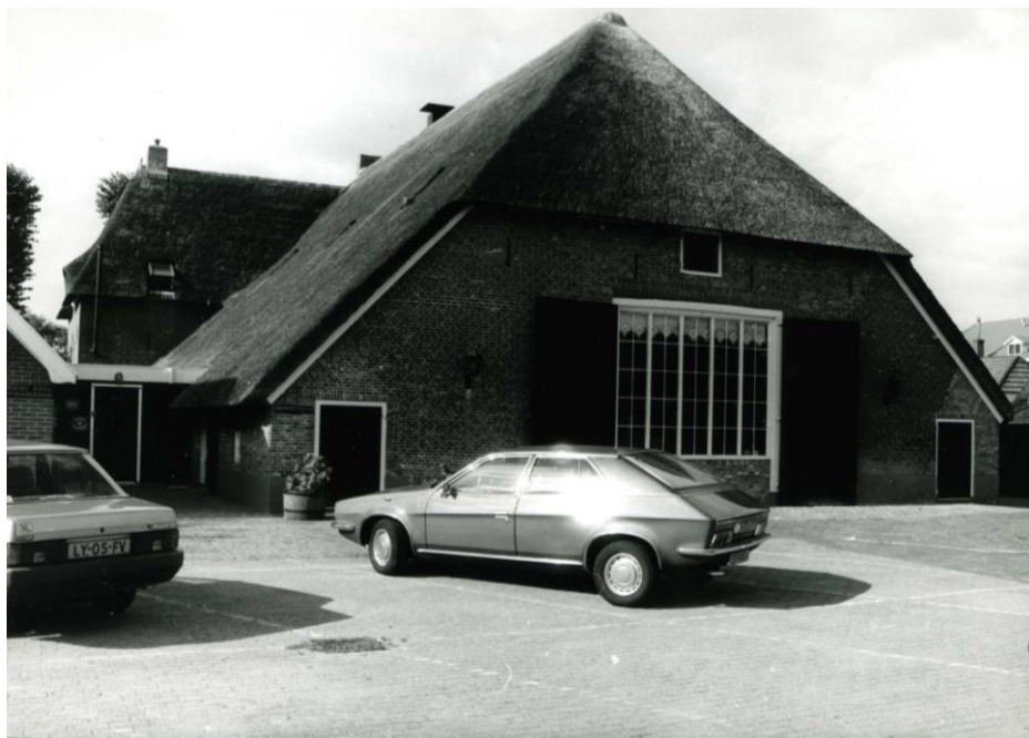
Boerderij vanuit het oosten, 1986. Bron: Beeldbank Overijssel.
