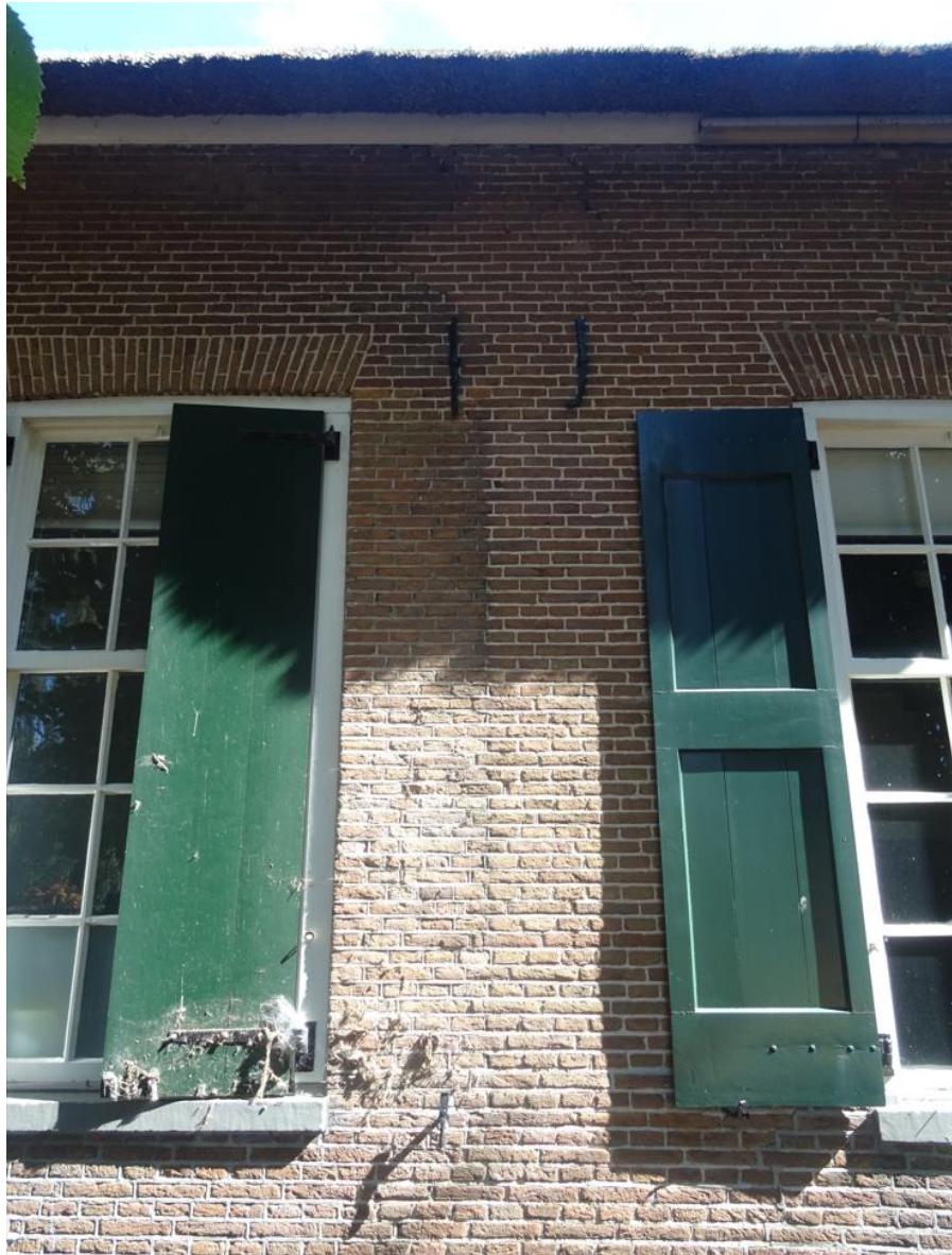
Vorgevel: bouwsporen in het tweede penant vanaf links.
