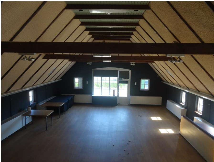
Impressie constructie schuur 1976.
