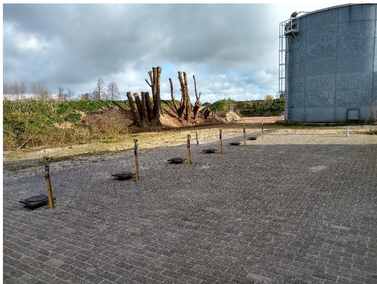
Figuur 3.1 Ondergrondse opslagtanks
