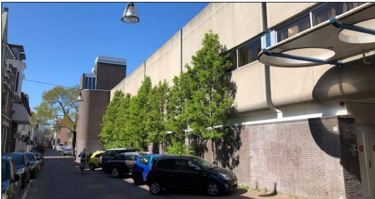
Begrenzing van het pand aan de Nieuwstraat. Op de hoek is de uitbouw op de hoek Nieuwstraat – Broerenstraat zichtbaar.
