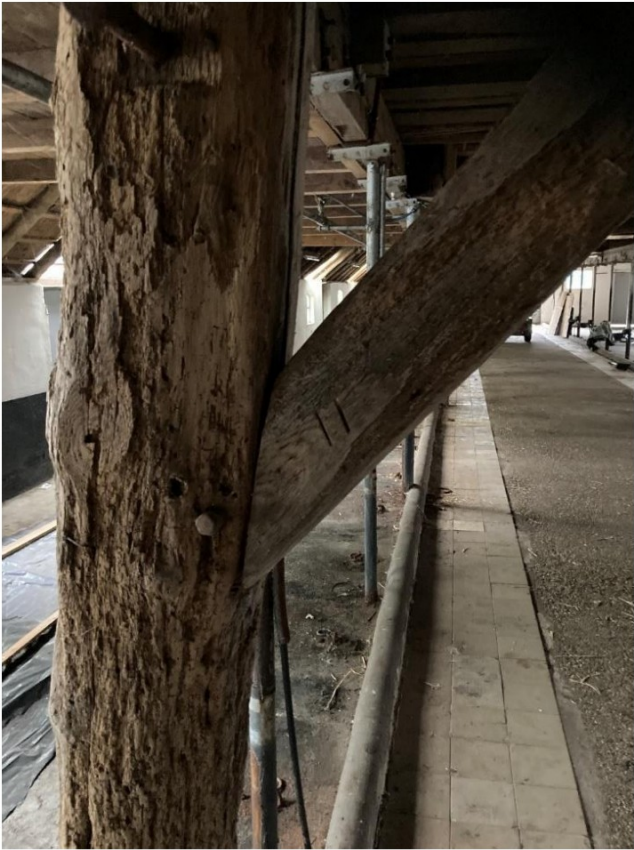
Fig. 24 en 25; Gebint met telmerk II en penverbinding. Aantasting te zien, ook bij gebintstijl nr.3
