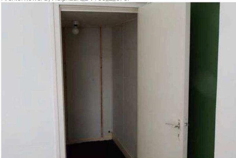
Afb. 3: Tot kastriumte verbouwd gedeelte van de lichthof
