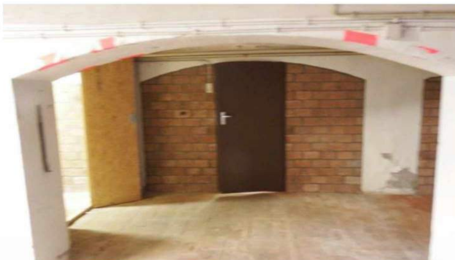
Afb. 25: Kelder met een in poriso-steen dichtgezette doorgang
