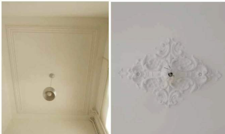
Afb. 23: Gestucte plafond met perklijsten (links) en middenrozet (rechts).
