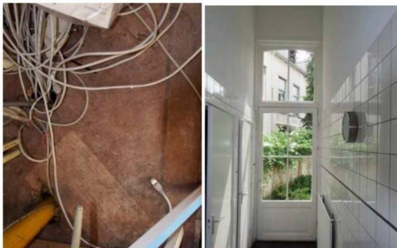
Afb. 27: In de stoppenkast doorlopende parketvloer (links) en de smalle middengang (rechts).
