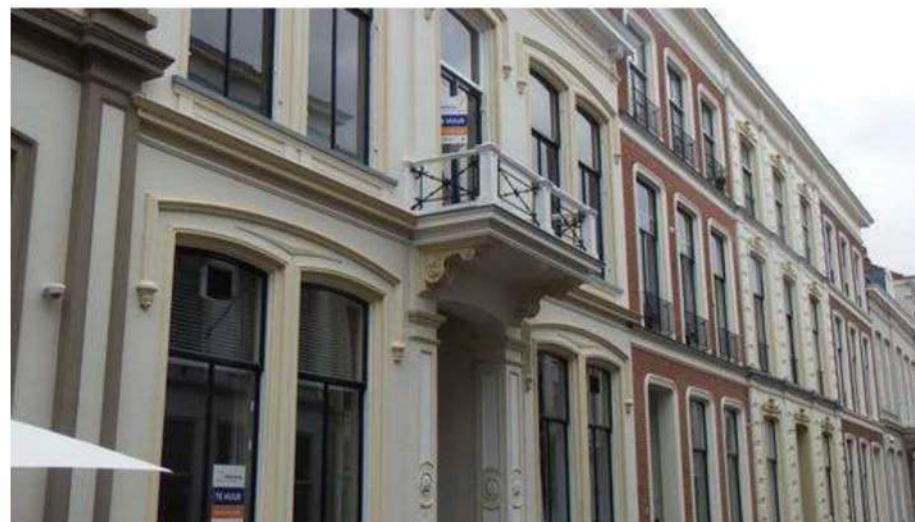
Afb. 31: Links de voorgevel van het onderzochte herenhuis als onderdeel van de gevelwand van gelijkvormige openingen aan de Keizerstraat..
