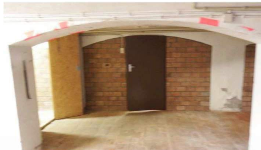
Afb. 6: Kelder met een in poriso-steen dichtgezette doorgang
