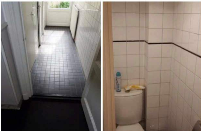
Afb. 46: Links de tegelvloer in de smalle middengang en rechts het wandtegelwerk in de toiletruimten.
