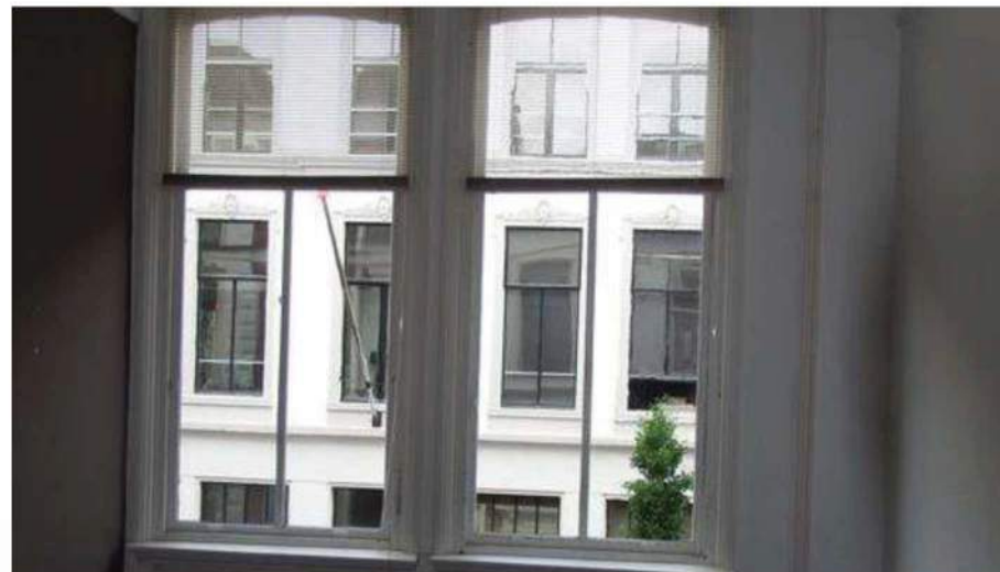
Afb. 47: Vensters in de voorgevel met omlijsting.
