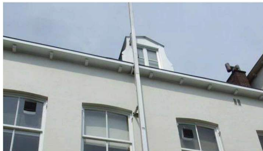
Afb. 35: Dakkapel in de dakvoet. Op de gevel is een vluchtladder gemonteerd.
