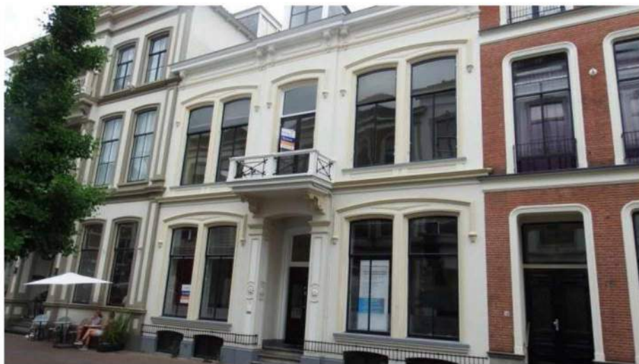
Afb. 30: Voorgevel van het onderzochte herenhuis aan de Keizerstraat
