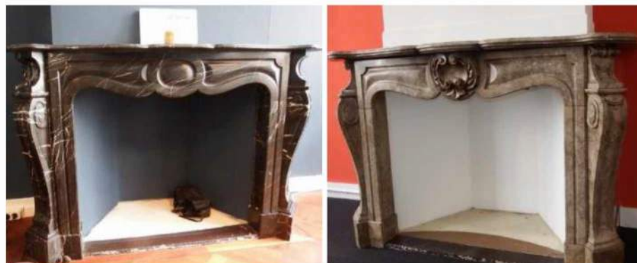
Afb. 41: Vuurmond links in marmer-imitatie en rechts in de natuurstenen uitvoering.
