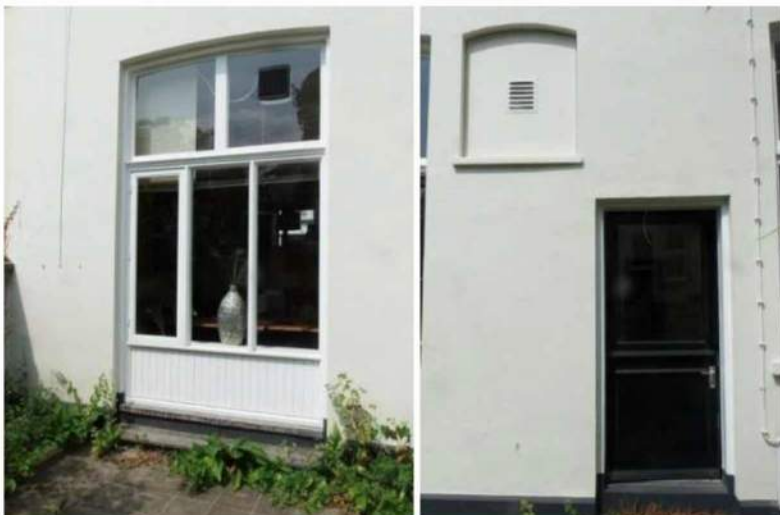
Afb. 36: Links de linker opening met de ingevulde 3-lichtspui en rechts een afgeplaat bovenlicht en een deuropening naar de voormalige keuken.
