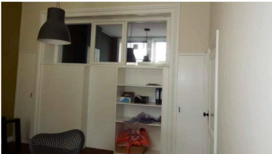
Afb. 42: Kastenwand met bovenlichten in de omijste opening gezien naar de voorgevel. Links en rechts van deze opening zijn oorspronkelijke kasten met deuren zichtbaar.
