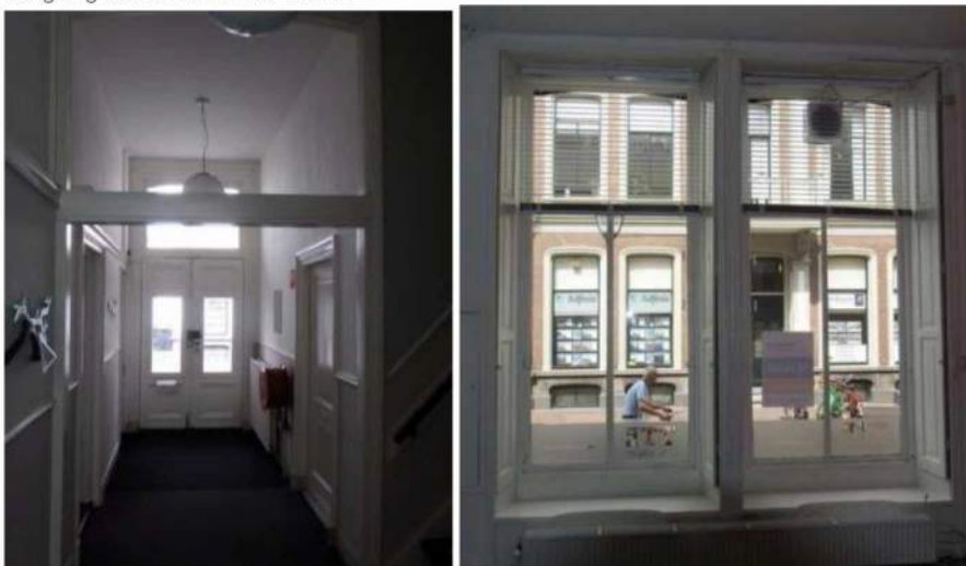
Afb. 40: Links de brede middengang gezien naar de entree en rechts de voorzetwand van het rechter vertrek met binnenluiken en vensterbanken.
