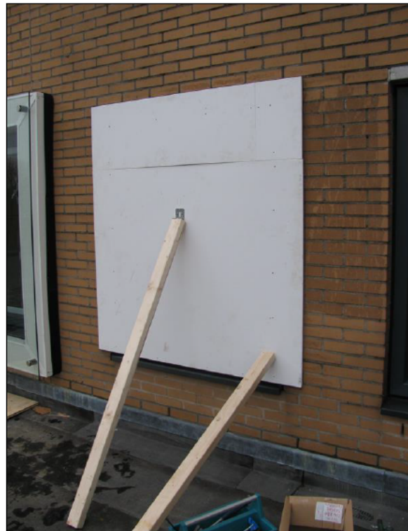
Foto II.4 Provisorische afdichting tweede raam
