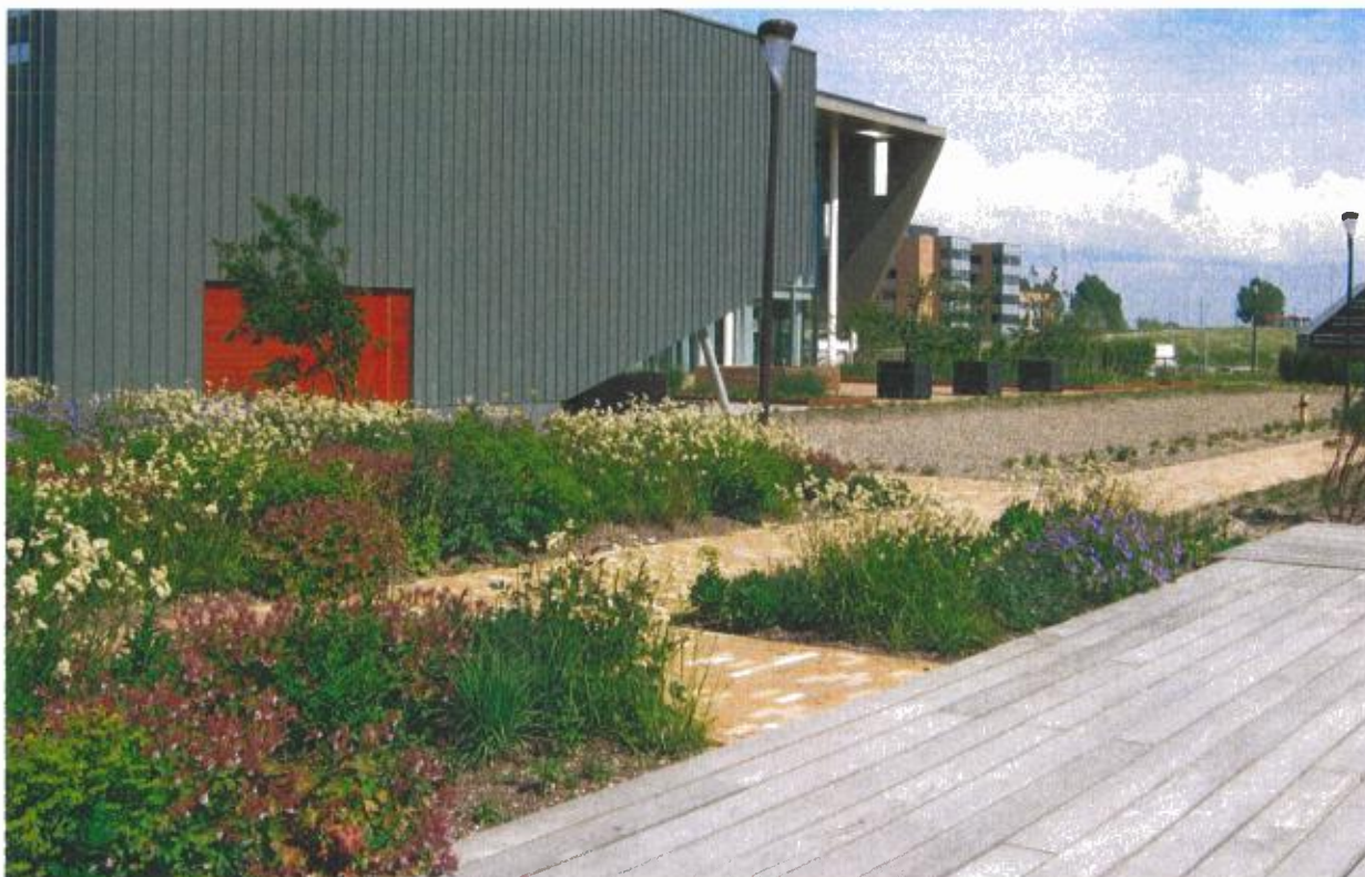
Figuur 11: Verblijfsdak op kelderdek (kantoor FifPro Hoofddorp)
